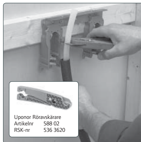
2. Kapa Wirsbo PEX-röret med Uponor Röravskärare.
