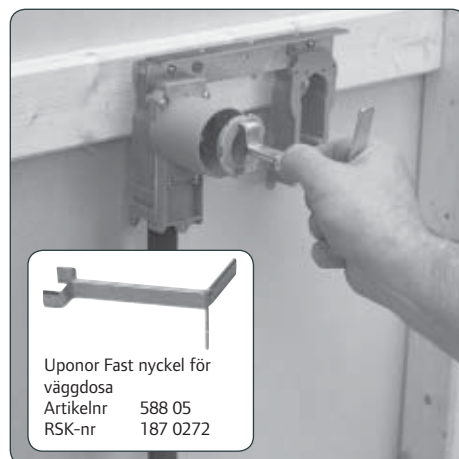
6. Fixera koppling med Uponor Fixeringskiva.
