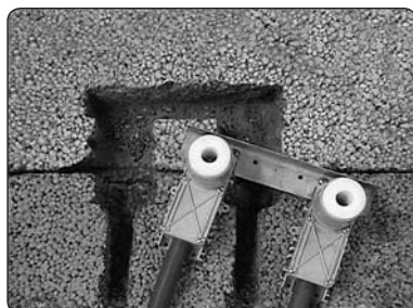
Bild 6, Dosor i murvägg
