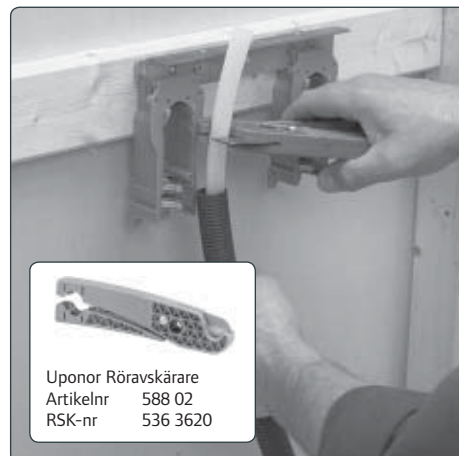
2. Kapa Wirsbo-PEX-röret med Uponor Röravskärare.
