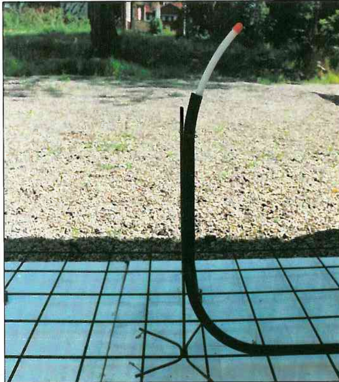
Bild 17a. Förläggning i betongbjälklag. Obs. skyddsproppen längst ut på röret förhindrar att betongvatten mm kommer in i röret under byggnadsprocessen.
