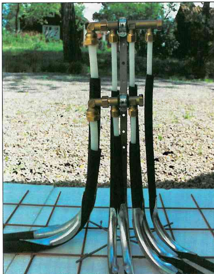
Bild 17b. Fördelarkonsol
