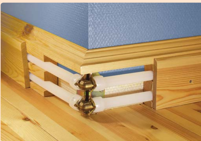
Exempel på installerat ytterhörn
