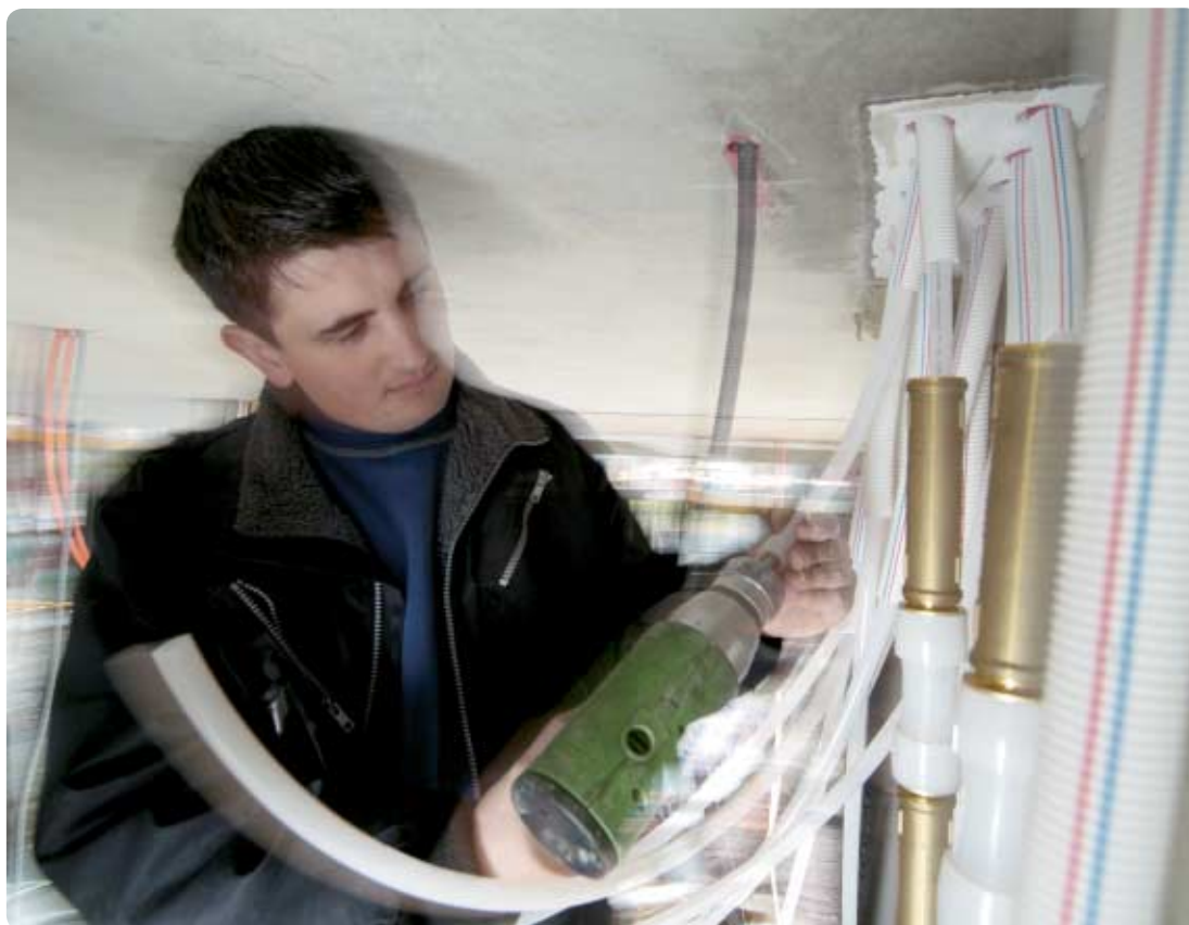
Med Q&E-kopplingar och ett batteridrivet expansionsverktyg, går installationen blixtsnabbt oavsett om röret används till tappvatten eller värme.
