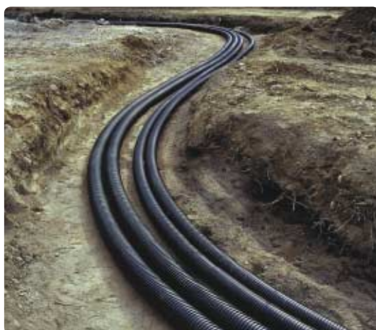
Långa skarvlösa längder på rulle gör installationen enkel, snabb och prismässigt mycket konkurrenskraftig.
