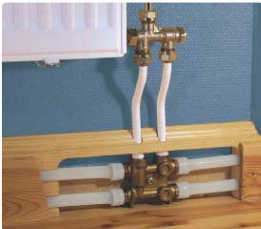
Uponor Golvsockel - ett bra exempel på en snillrik dold konstruktion av radiatorrör.
