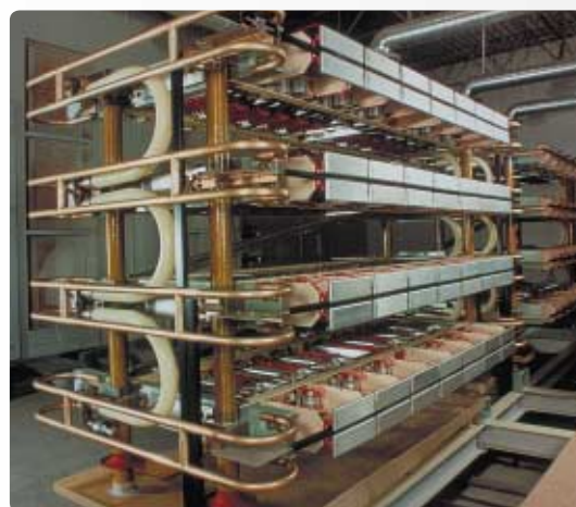
Wirubo-inPEX-rör används som kylvattenrör i högspänningstyrister och faskompenseringsutrustning.
