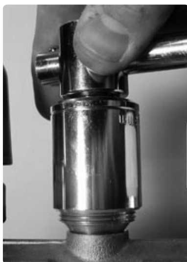
Spänn fasten ventilen med den fasta nyckeln och montera tillbaka styrdonet.
