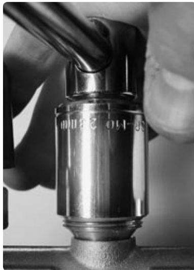
Lossa ventilöverdelen med en förslagsvis fastnyckel eller hylsnyckel dimension 23 mm.
