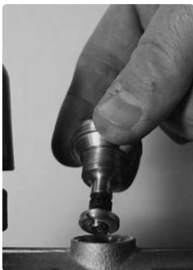
Sätt i den nya ventilöverdelen med ett spår i ventilkäglan.
