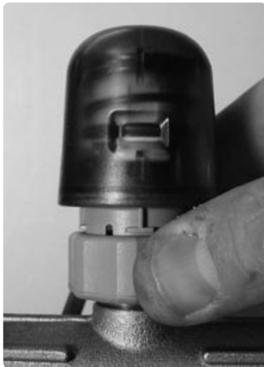
Lossa styrdonet för den slinga som betjänar rummet med braskaminen.
