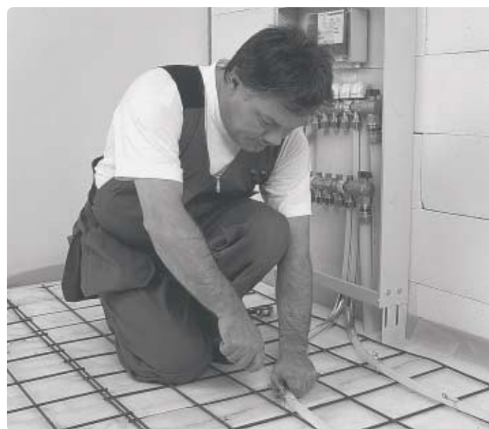
Golvvärmerör najas mot armeringsjärn
